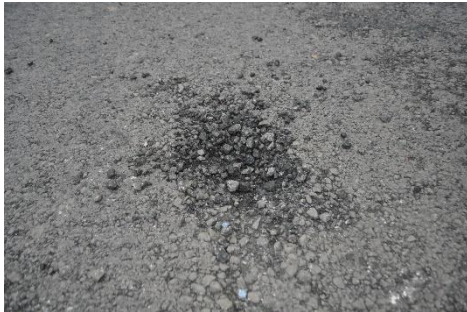
Abb. 4: Asphalterschadstelle
